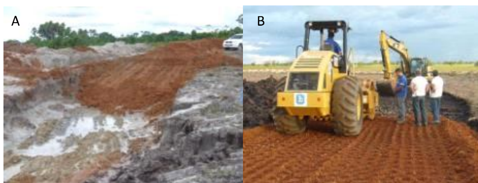
A – Preenchimento de núcleo de talude com material de alta qualidade para aumentar a estabilidade e reduzir a infiltração do talude. B – Compactação de material de núcleo com rolo compactador auto propelado.
