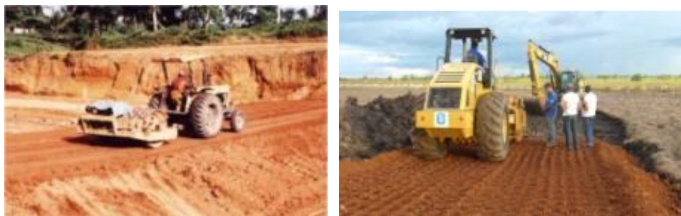
Rolo compactador puxado por trator. Rolo compactador auto propelido compactando a base de um talude.
