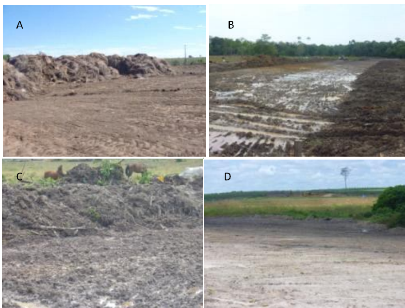
Exemplos de limpeza de área: A – Raspagem com trator de esteira em terreno seco para ser removido posteriormente; B – Limpeza em terreno úmido com escavadeira hidráulica; C – Material removido do terreno; D – Raspagem de material orgânico para a borda do terreno.
