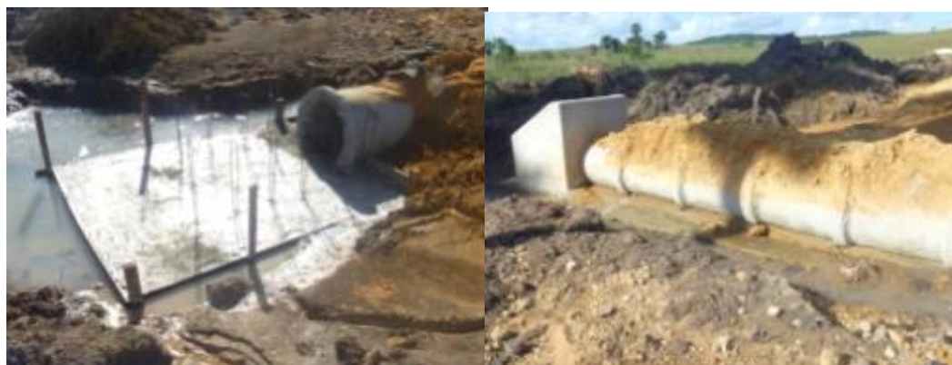
Fotos: Detalhes da etapa inicial da construção do monge.
