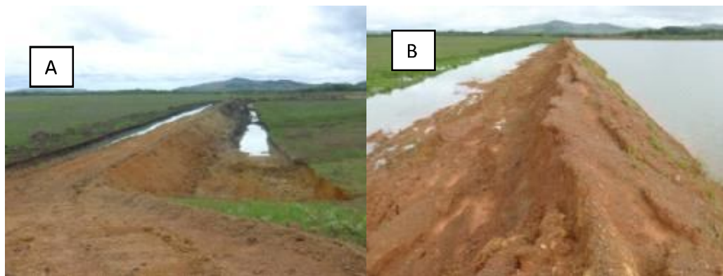
Fotos de um talude de açude antes (A) e depois (B) da água passar por cima do mesmo. Houve perda de peixes e todo o investimento teve que ser refeito.
