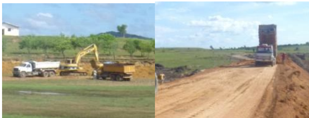
Caminhões sendo carregados por escavadeira hidráulica. Caminhão descarregando material para construção de talude de açude.
